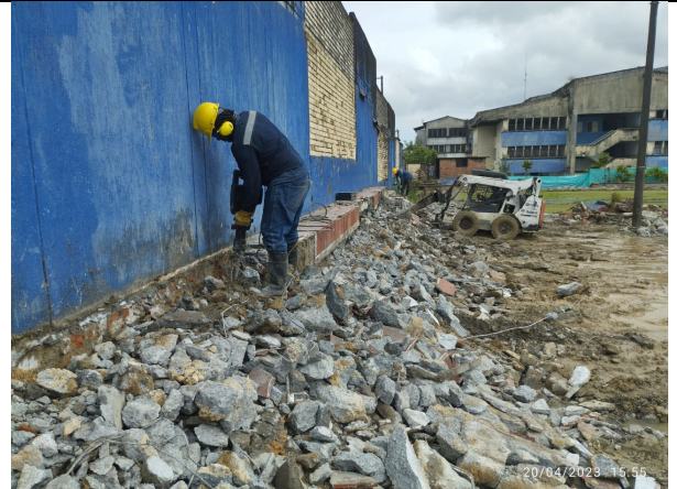
Demolición de gradería en concreto
