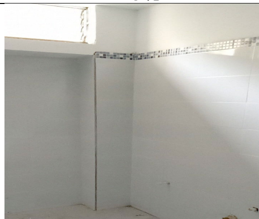
Instalación de enchape en baterías sanitarias de niños
