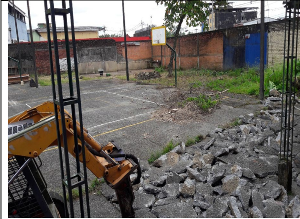
Demolición de losa – área de cancha.
