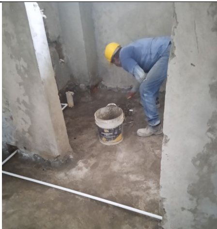
Instalación de tubería PVC ½"
