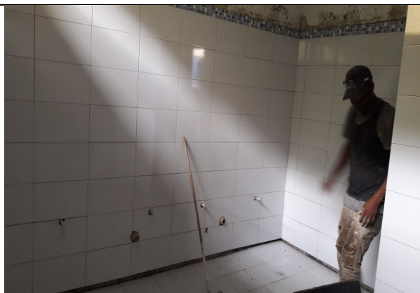
Instalación de enchape en baterías sanitarias de niños
