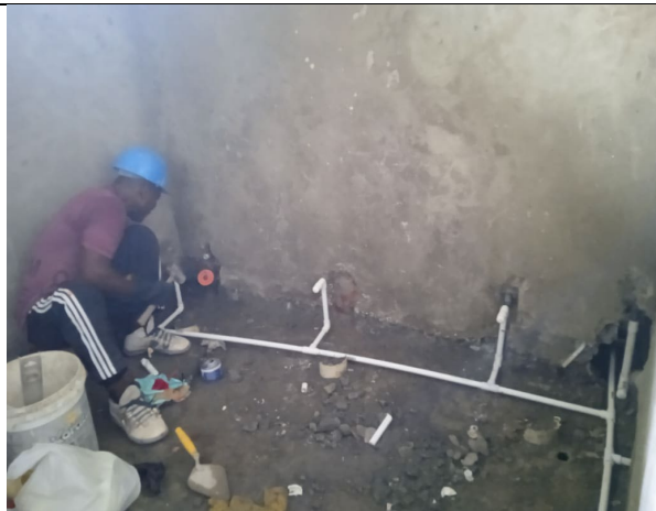
Instalación de puntos hidráulicos PVC ½"
